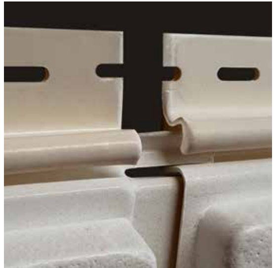
Рис. 14 Усиление жёсткости вертикального соединения панелей (необходимо выполнять при отдалении стойки обрешётки на расстоянии более 100 мм)
